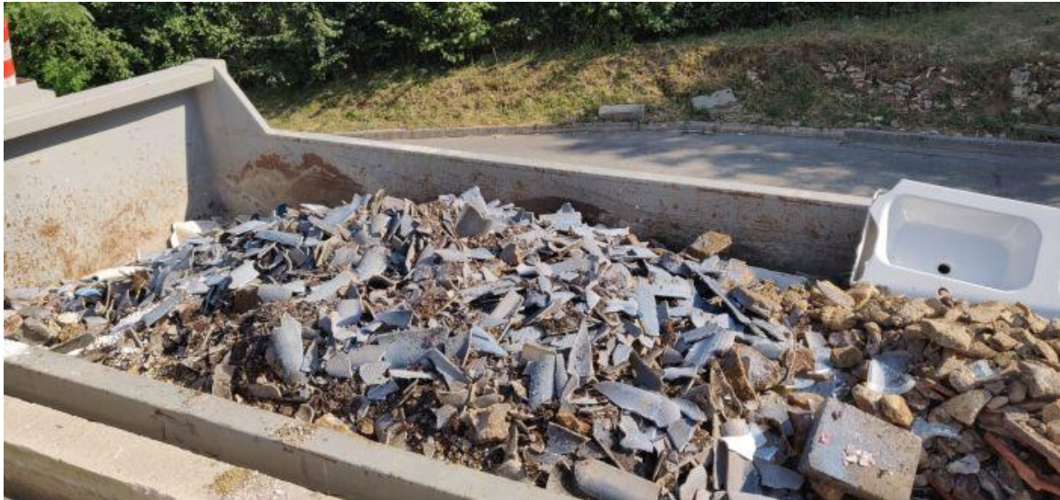
Le dépôt suspect constaté dans la benne " Gravats ".
