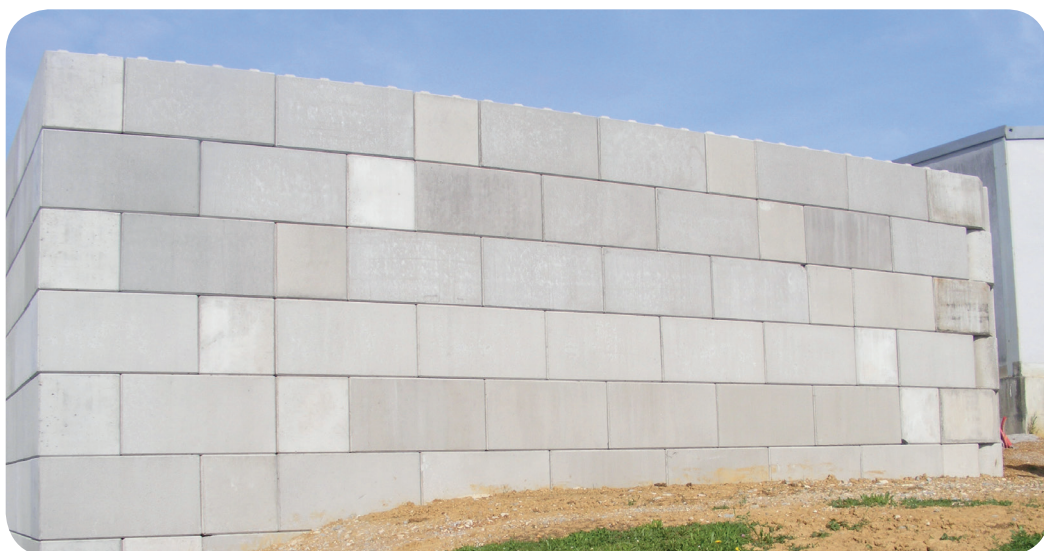
Mur côté local de vie
