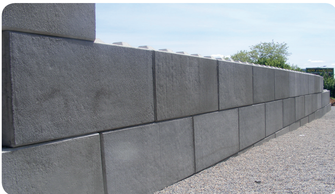
Mur côté rue Thomas Edison
